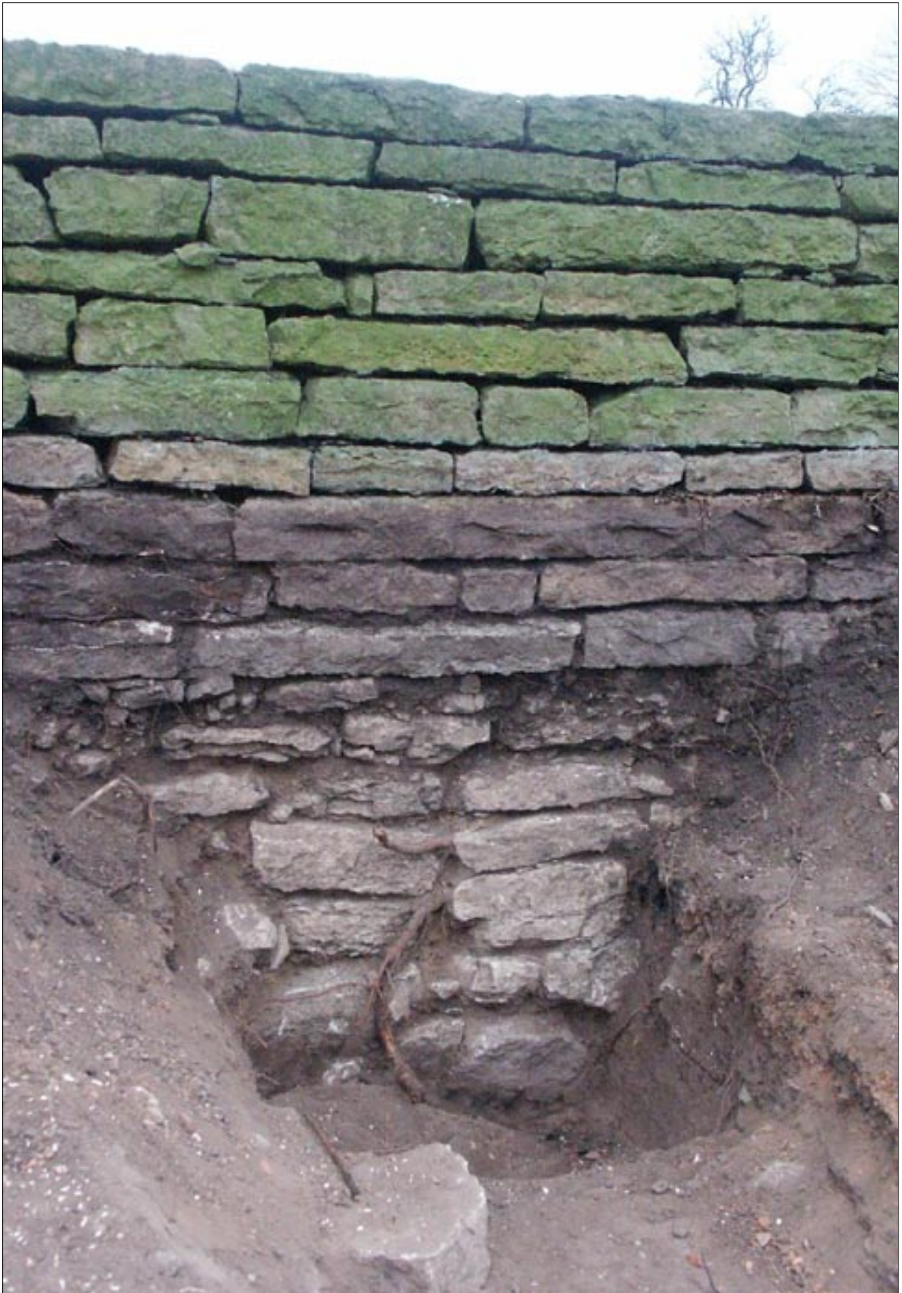
Fig 13. Område nr 3, schakt 4, i botten rester efter äldsta kyrkogårdsmuren, övre delen uppbyggd under 1900-talet (?). Foto RAÄ, UV Öst.
