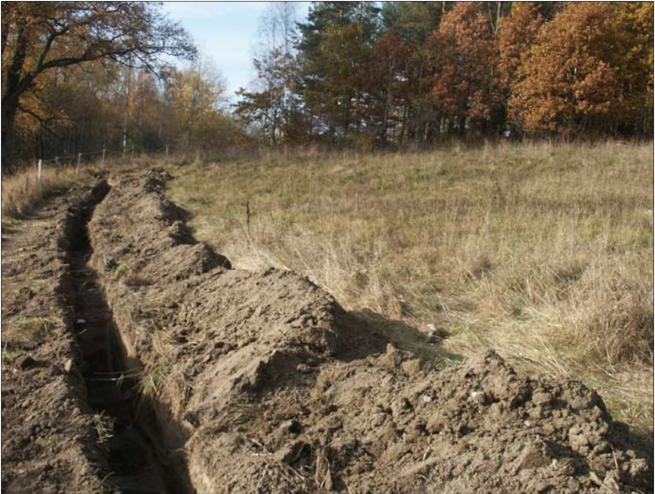
Fig 5. Boplatsplatån och schakt 2 sett från öster. Foto Linus Hagberg.
