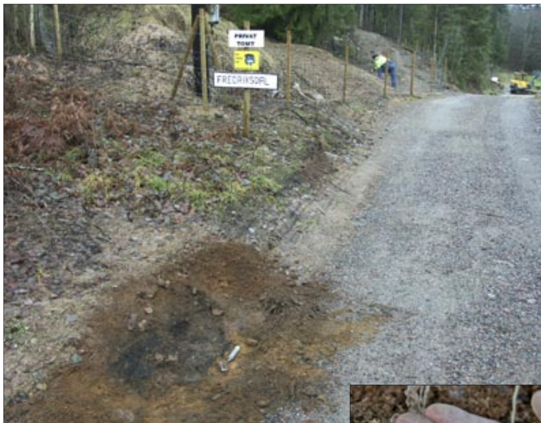
Fig 18 (ovan). Ytterligare en härdgrop har rensats fram i kanten av grusvägen. Den nya V/A-ledningen är nedgrävd i vägkanten och fortsätter vidare upp i moränsluttningen i bildens överkant, inom det inhägnade området. Grävmaskinen gräver för ny dränering vid Fredriksdal. Foto Fredrik Molin.
