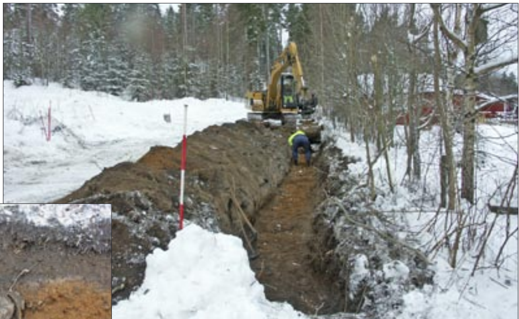
Fig 10 (t v). Stratigrafi i S57. Under skikt av sandig matjord från den tidigare åkern, samt ett tunt sandlager från vägbygget, låg ett bevarat kulturlager av sotig sand. Fotot visar ett stenscott stolphål , A81 samt det askgrå marklager som utgjorde den övre delen av undergrunden i området. Foto Fredrik Molin.
