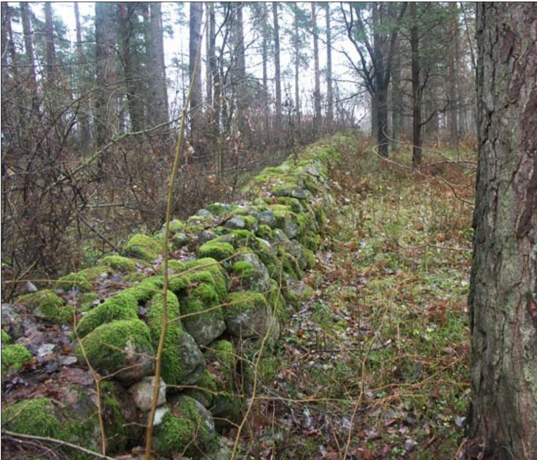
Fig 3. Muren. Från V. Foto Katarina Sköld.
