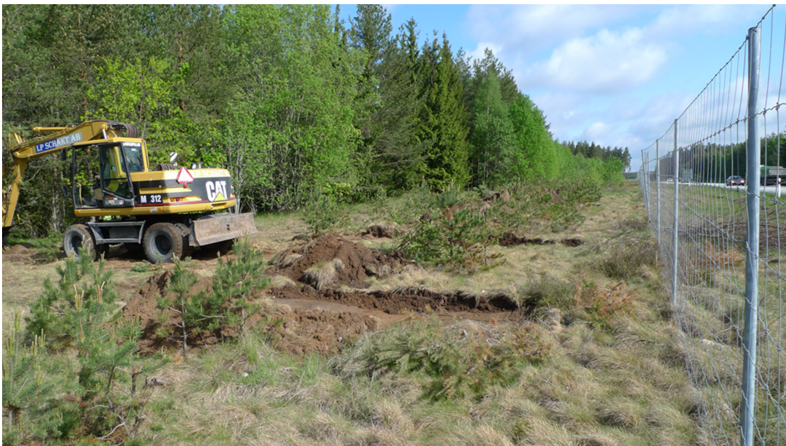
Fig 4. Avbaning inom västra undersökningsområdet. Foto från söder av Emma Sjöling, SAU.
