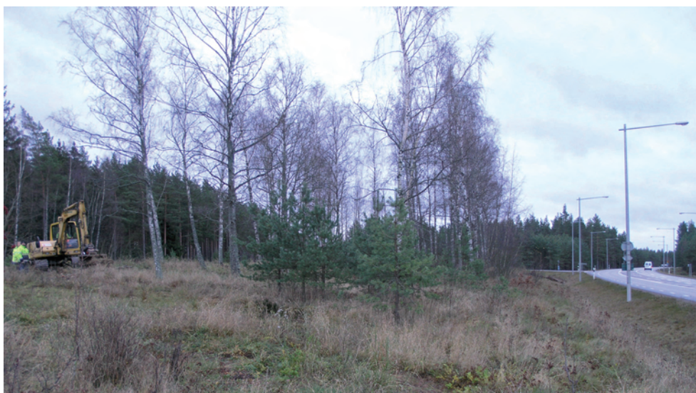
Figur 3. Översiktspåtag, gravfältet Högby 87:1. Grävmaskinen på bilden står i den nordligaste delen av gravfältet. Fotograferat från NNV. Till höger i bild syns väg 32 som ska breddas. 1992 års undersökningsområde av gravfältet sträckte sig ungefär fram till trädgränsen till vänster om vägen. Foto: Jan Åhlström.
