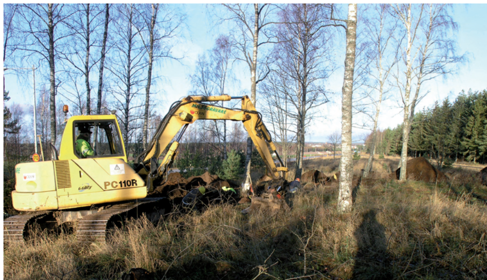
Figur 2. Den norra delen av gravfältet Högby 87:1. På bilden syns gravfältets inklämda läge mellan väg 32 till vänster i bild och cykelbanan till höger i bild. Fotograferat från söder av Anna-Lena Hallgren.
