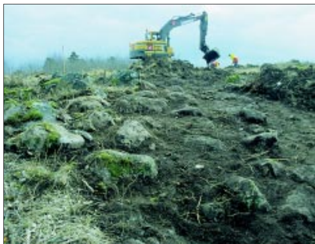
Fig 8. Delar av stensättningen A550 har frilagts med hjälp av grävmaskin. Graven är fylld av en grovblockig packning. Foto Annika Helander.
