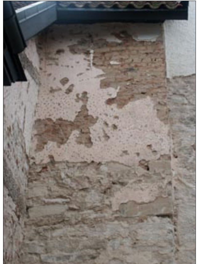
Fig 31. Landeryds kyrka. Nordvästra hörnet av långhusmuren, förhöjning samt rester av rosa puts. Foto från norr, RAÄ UV Öst.
