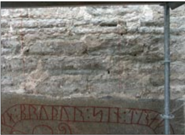
Fig 19. Landeryds kyrka. Tornet, södra fasaden, sekundärt infogad runsten. Foto från söder, RAÄ UV Öst.
