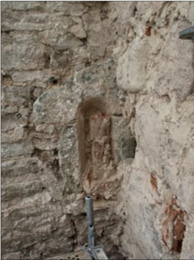
Fig 15. Landeryds kyrka, långhusets södra del, murverk fas 1. Foto från söder, detalj av sekundärt inmurat romanskt fönster, Foto RAÄ UV Öst.
