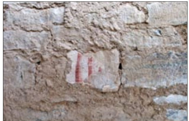
Fig 32. Landeryds kyrka. Södra långhusmuren, med sekundärt inmurad tegelsten med bevarade målningsfragment. Foto RAÄ UV Öst.
