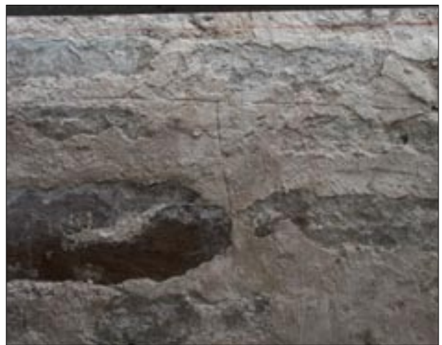
Fig 14. Landeryds kyrka, långhusets södra del, murverk fas 1. Detalj av kvaderritsning. Foto från söder, RAÄ UV Öst.
