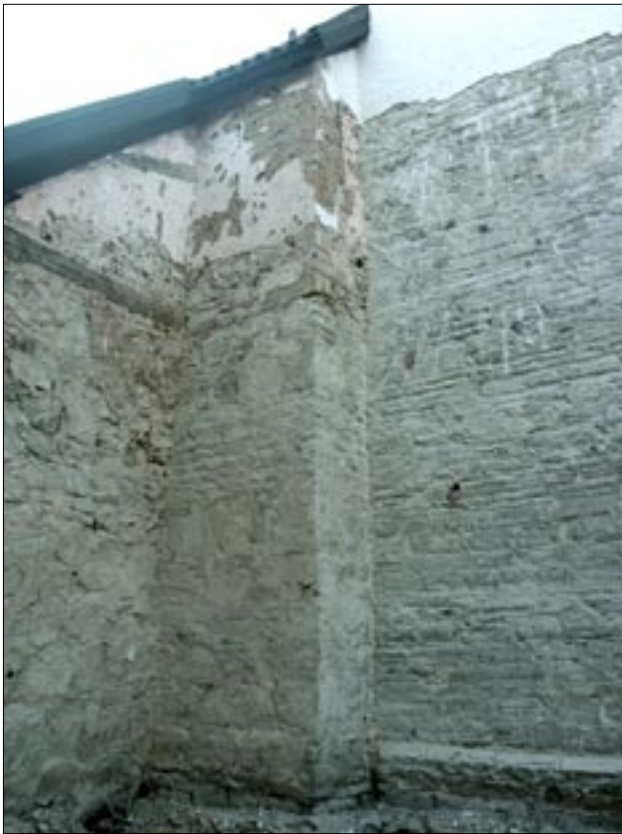
Fig 11. Landeryds kyrka, långhusets norra del, murverk fas 1. Foto från NV, RAÄ UV Öst 2004.
