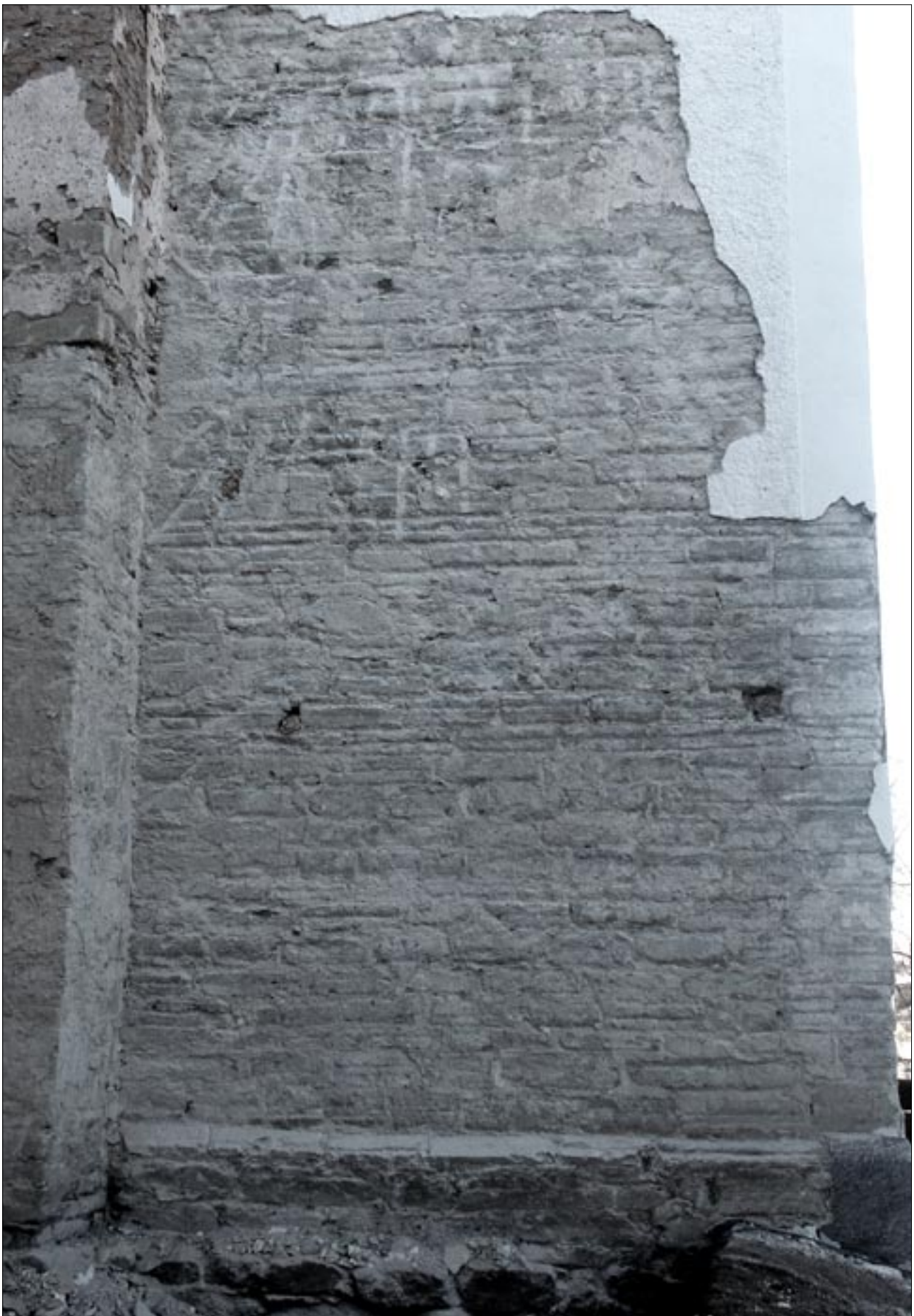
Fig 17. Landeryds kyrka. Tornet, norra fasaden, murverk fas 2. Foto från norr, RAÄ UV Öst.
