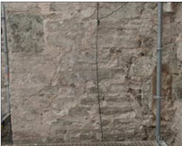
Fig 13. Landeryds kyrka, långhusets södra del, murverk fas 1. Foto från söder, RAÄ UV Öst.
