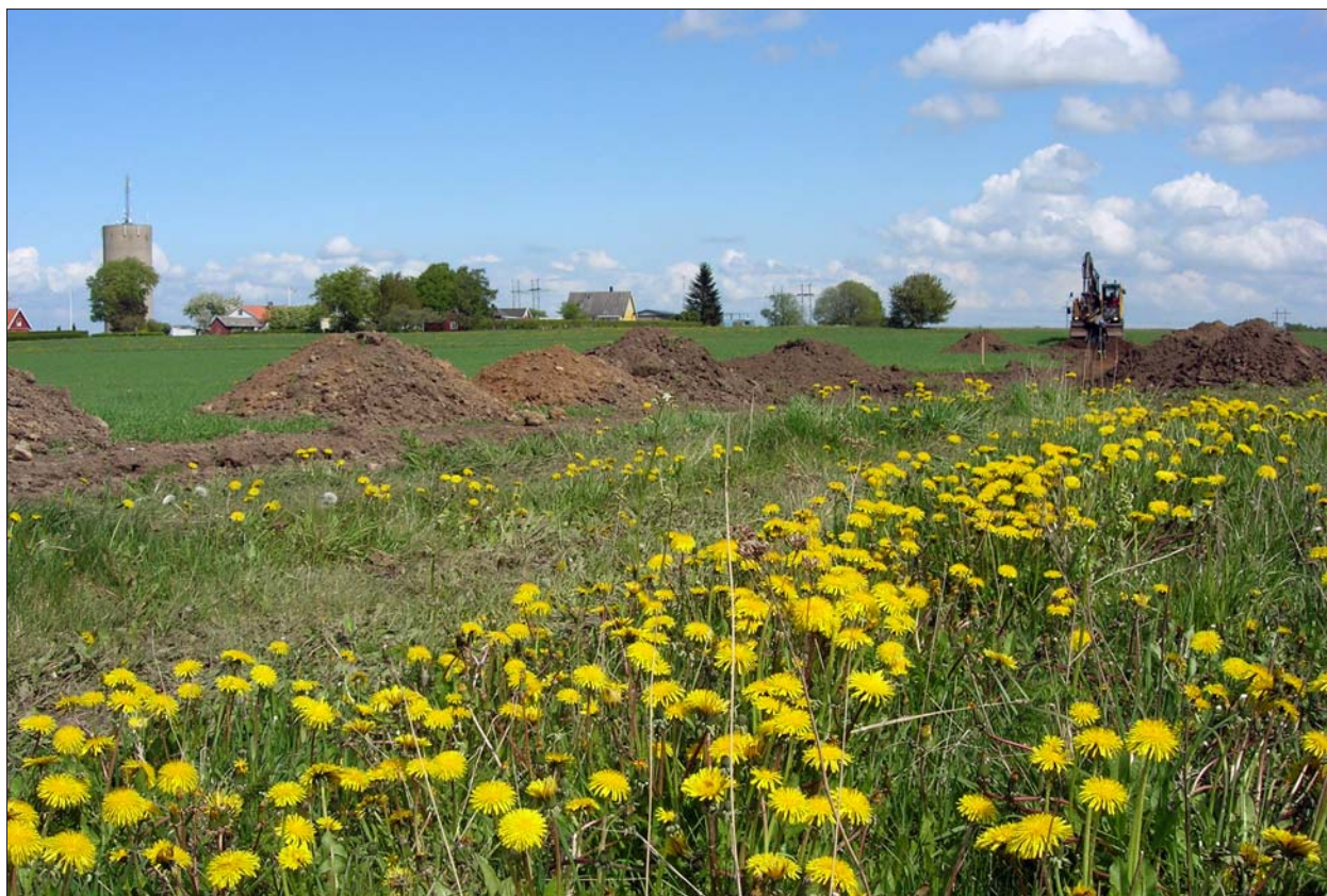
Figur 3. Vadstena vattentorn är beläget på krönet av Kvarnbacken. Schaktning vid grav- och boplatssområde RAÄ 44 (Vadstena stad). Foto mot nordöst, Emma Karlsson, ÖLM.
