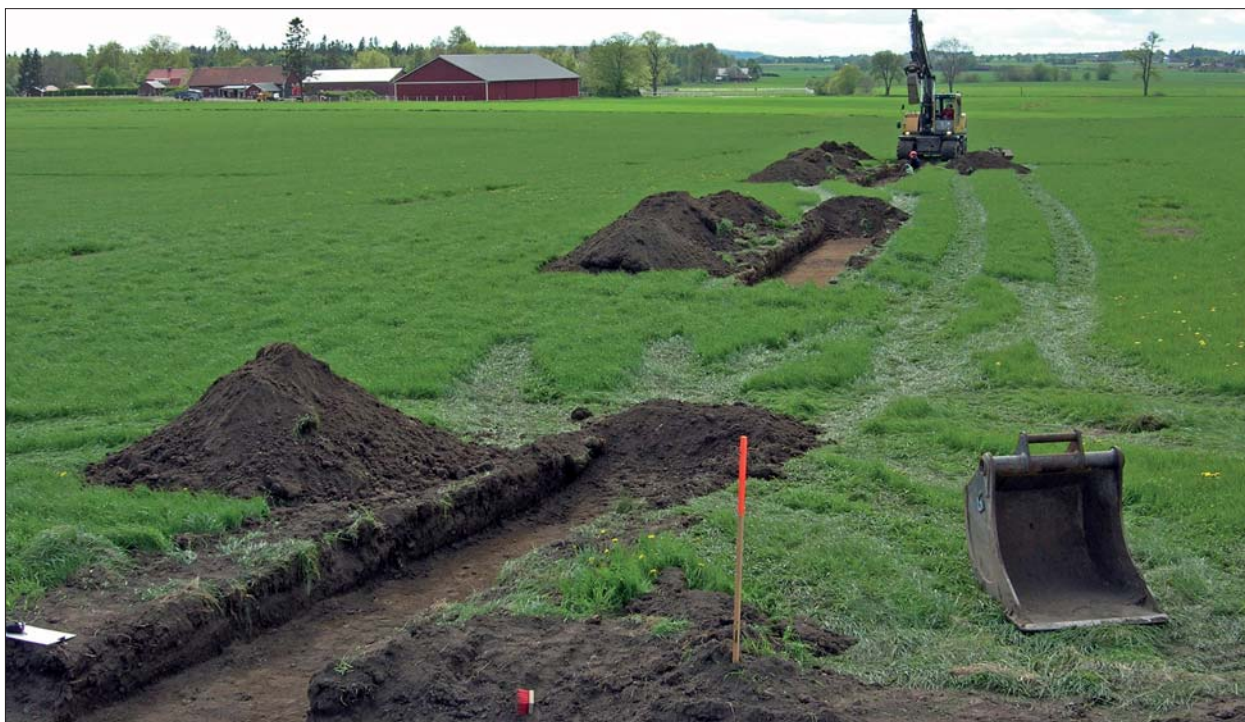
Figur 27. Schaktning vid RAÄ 44 (område I och II). I bakgrunden syns fastigheten Solhaga. Foto mot väster, Emma Karlsson, ÖLM.
