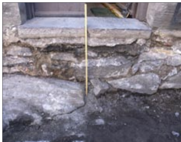
Fig 7. Grunden med den infällda tröskeln. Grundens östra del (bildens vänstra sida) var delvis uppförd direkt på det befintliga berget. Foto Magnus Stibéus.
