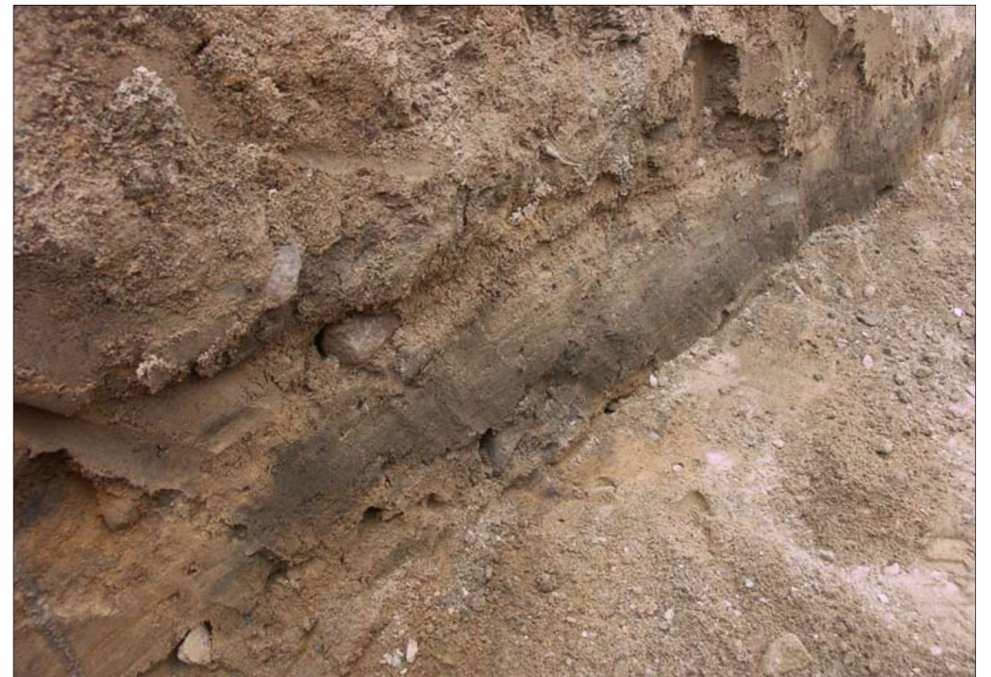
Fig 7. Fjärrvärmeschaktet går under Storgatan. Till vänster i botten på schaktväggen skimtar lager 1, schakt 4 i område 3. Foto från söder. Bengt Elfstrand.
