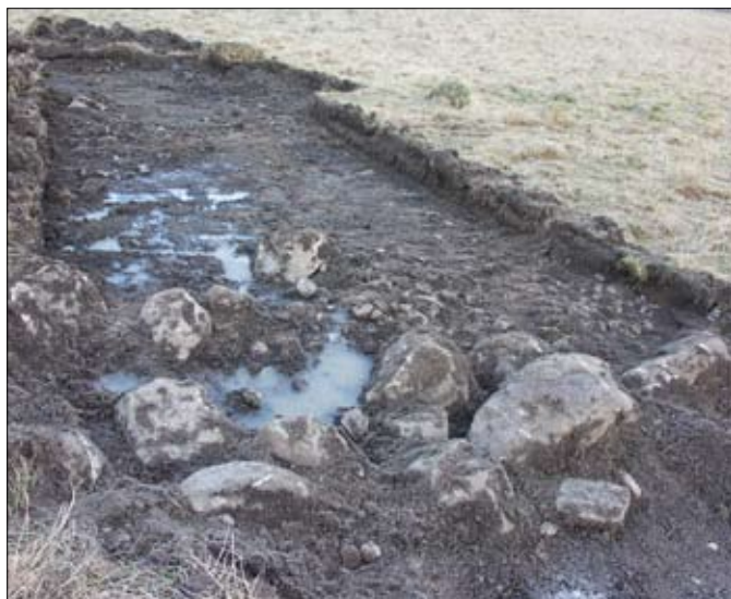
Fig 9. Stensträngen och stenpackningen är framschaktade. Foto Linus Hagberg.
