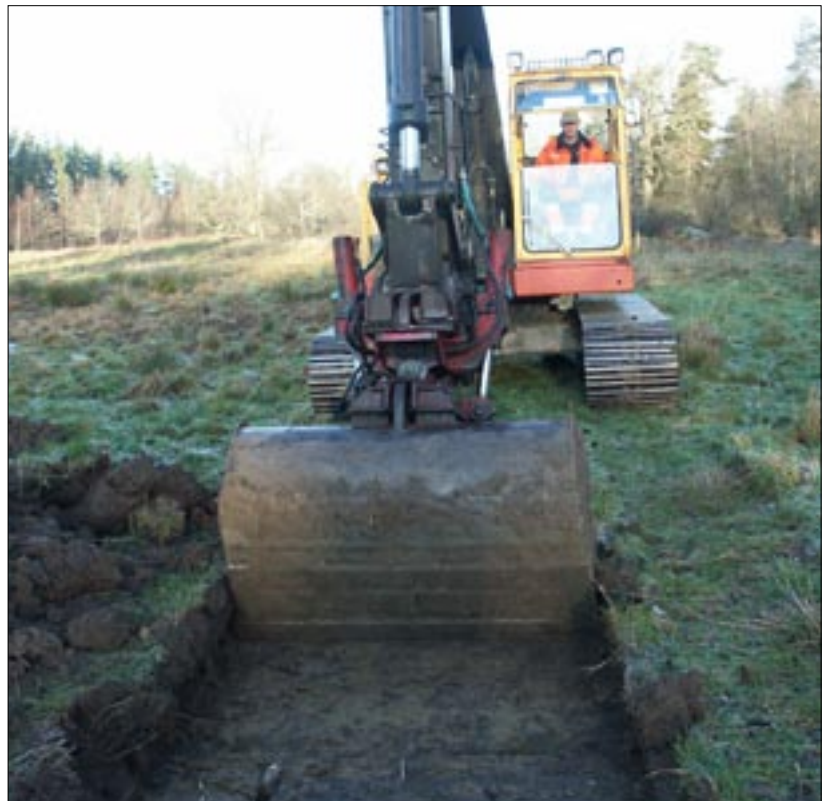
Fig 13. Arbetsfoto på sökschaktningen, Objekt 4, som utfördes med hjälp av grävmaskinist Stefan Candell. Foto från syd av Anders Kraft.
