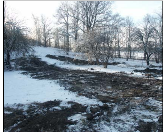
Fig. 5. Schakt 206 och 218 från N.
