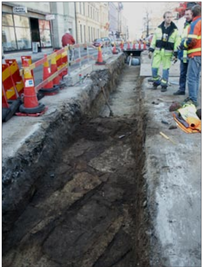
Fig 6. Västra delen av kyrkogården med framkomna gravar i schaktet. Foto från öster av Annika Konsmar.
