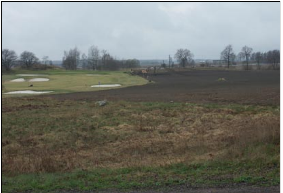
Fig 6. Schaktning inom Obj Ic (Omr A). I bakgrunden skymtar E4. Från Ö. Foto Per Nilsson.
