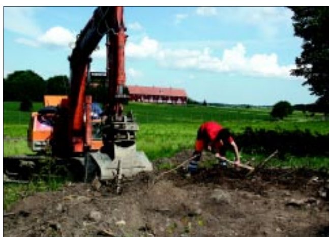
Fig 11. Schaktarbete vid höjdryggens fot, i bakgrunden syns Bökestad gård. Mot nordöst. Foto Lisa K Larsson.
